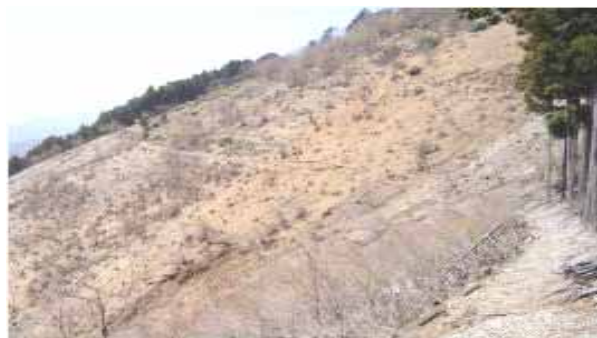
造林地における表土の流出
