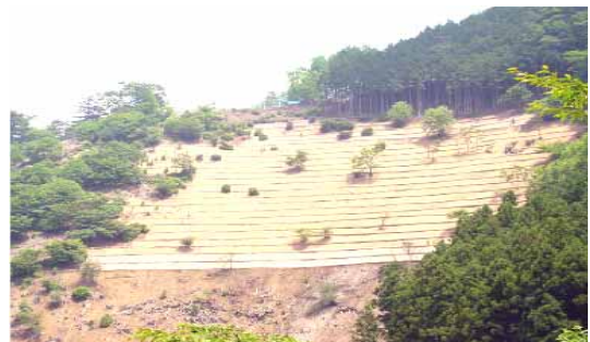
逆川上流（オオダワ）の治山工事
