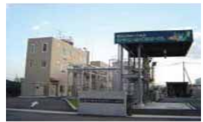
京都市の廃食用油燃料化プラント
