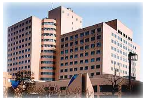
都立駒込病院
